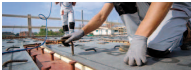
4. Particolare di inserimento del connettore a taglio nel foro riempito di resina.
