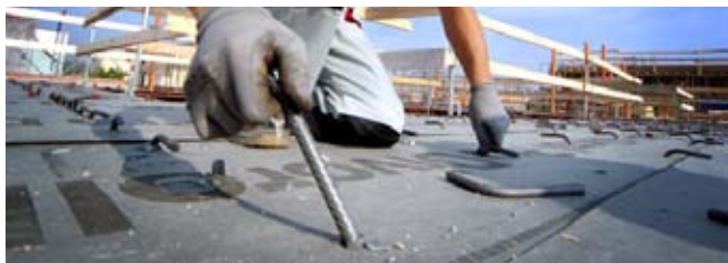
2. Particolare di inserimento del connettore a taglio nel foro riempito di resina.
