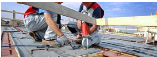
3. Particolare di inserimento del connettore a taglio nel foro riempito di resina.
