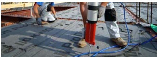
1. Particolare di iniezione della resina nei fori appena realizzati.
