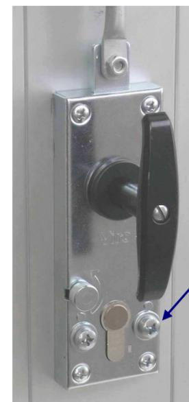
Viti che attraversano i fori a norma DIN per l'applicazione della rosetta di sicurezza.
