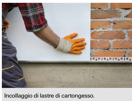
Incollaggio di pannelli isolanti in genere.
