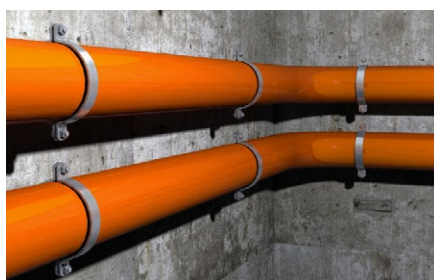
Fissaggio delle condotte in plastica.
